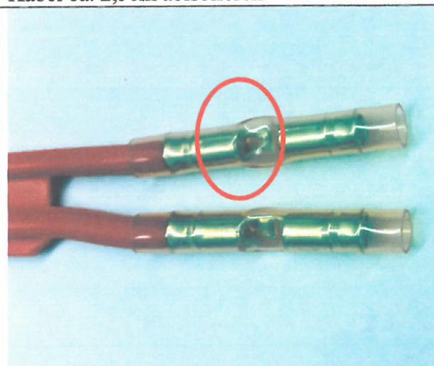
Verbinder auf das Kabel draufschieben, bis man Kupfer in der Mitte des Verbinders sieht.
