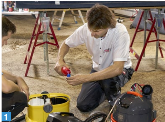
1 Reiniger und destilliertes Wasser kommen im vorgegebenen Mischungsverhältnis in den Waschsauger.
