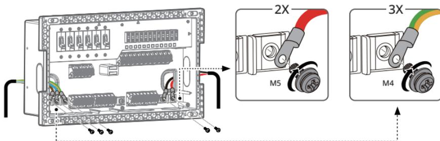
7. Öffnen Sie für jeden Stromkreis die Drahtschnapper und führen Sie die Lastdrähte entsprechend ein. Vergewissern Sie sich, dass jeder Draht fest eingerastet ist. Achten Sie bei Gleichstromkreisen darauf, dass die Sicherung entsprechend dem Laststrom gewählt wird, und setzen Sie die Sicherung in den entsprechenden Sicherungsschlitzein.
